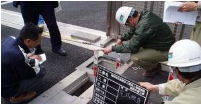
外構工事検査の様子（5月6日）
