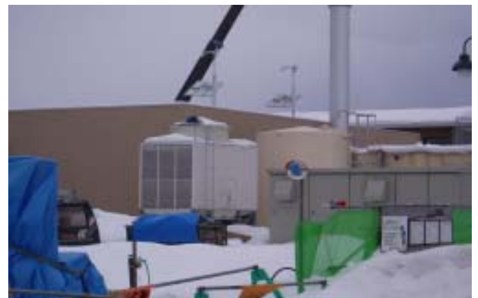
太陽光・風力発電ハイブリッドシステム
