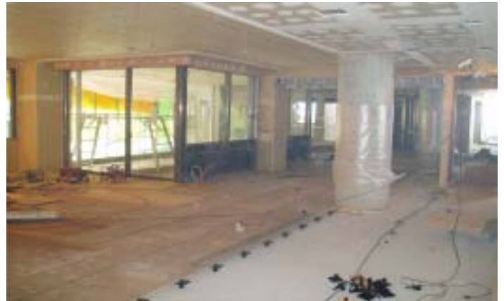
ユニット内床工事の様子
