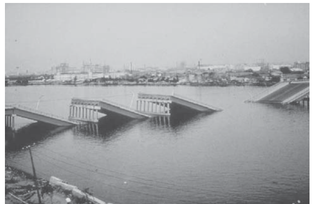
竣工したばかりで落橋した新潟の昭和大桥
