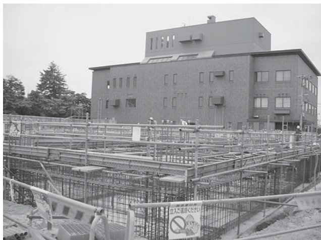
型枠鉄筋工事（6月10日）
