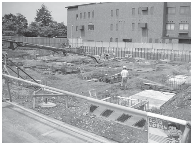
杭頭補強コンクリート打設（5月21日）
