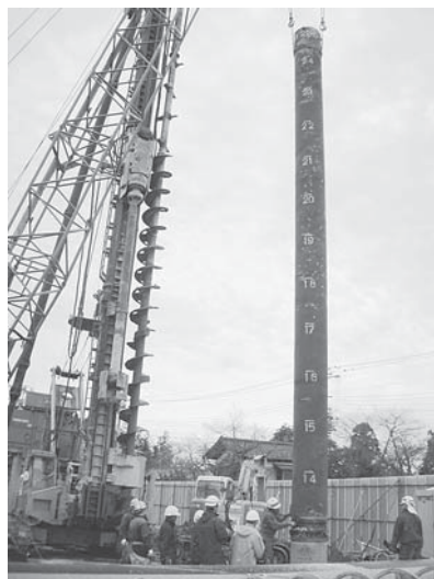
杭打作業の様子（3月31日）
