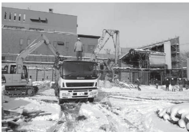
車庫の解体作業の様相（2月5日現在）
